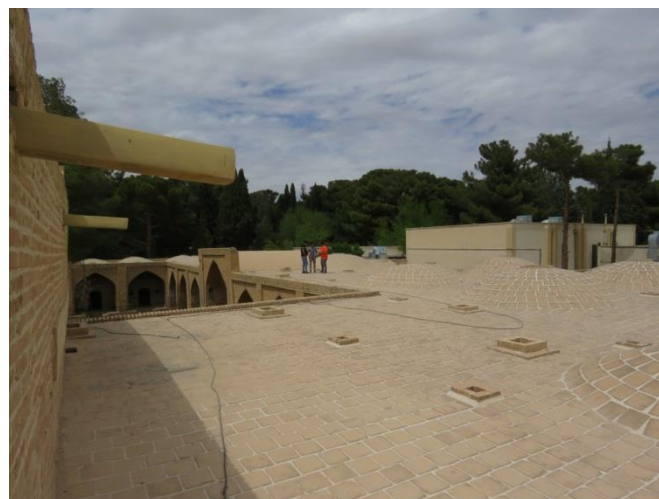
تصویر شماره ۴ - بام ضلع شرقی بنا
